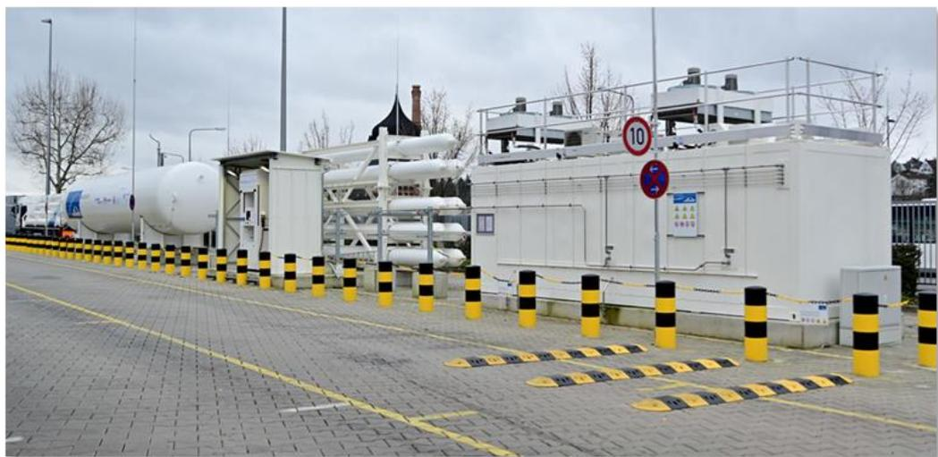
*Abb. 107: Wasserstoff-Tankstelle auf dem Betriebshof der ESWE Verkehr in Wiesbaden (Bild: ESWE)*
